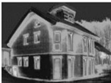
**Рисунок 1. Термограмма энергоэффективного дома в Липецкой области г. Грязи (в процессе постройки) февраль 2014 г.**
