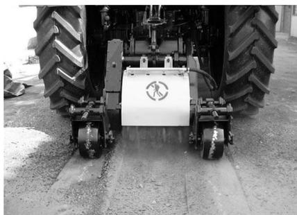
*Рисунок 1. Фреза для устройства виброполосы*
