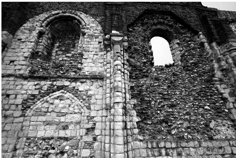
Рисунок 2. Стена северного придела церкви Сент-Огастин.
