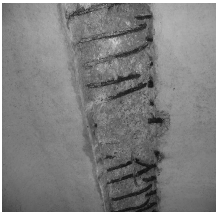
Рисунок 2. Карбонизация бетона и коррозия арматуры в защитном слое шва объединения балок
