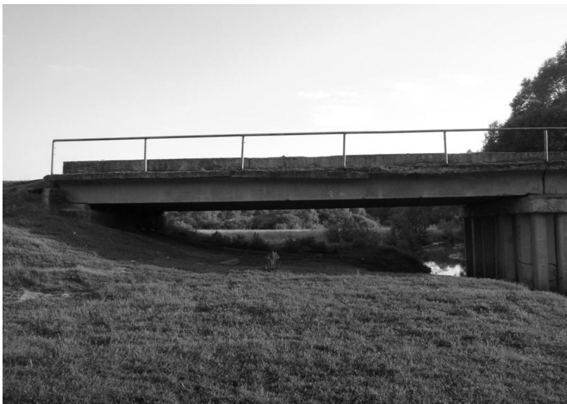
Рисунок 3. Разрезной железобетонный мост через р. Рогозна в д. Старково Курской области
