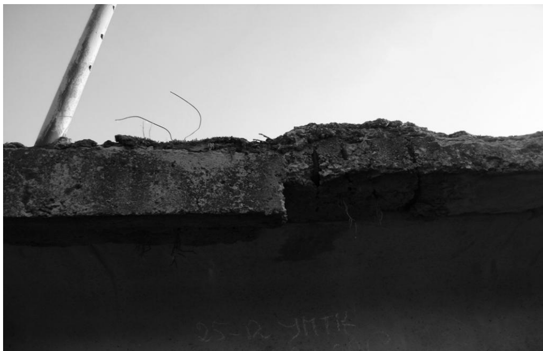
Рисунок 4. Разрушение железобетонной плиты проезжей части по фасаду моста
