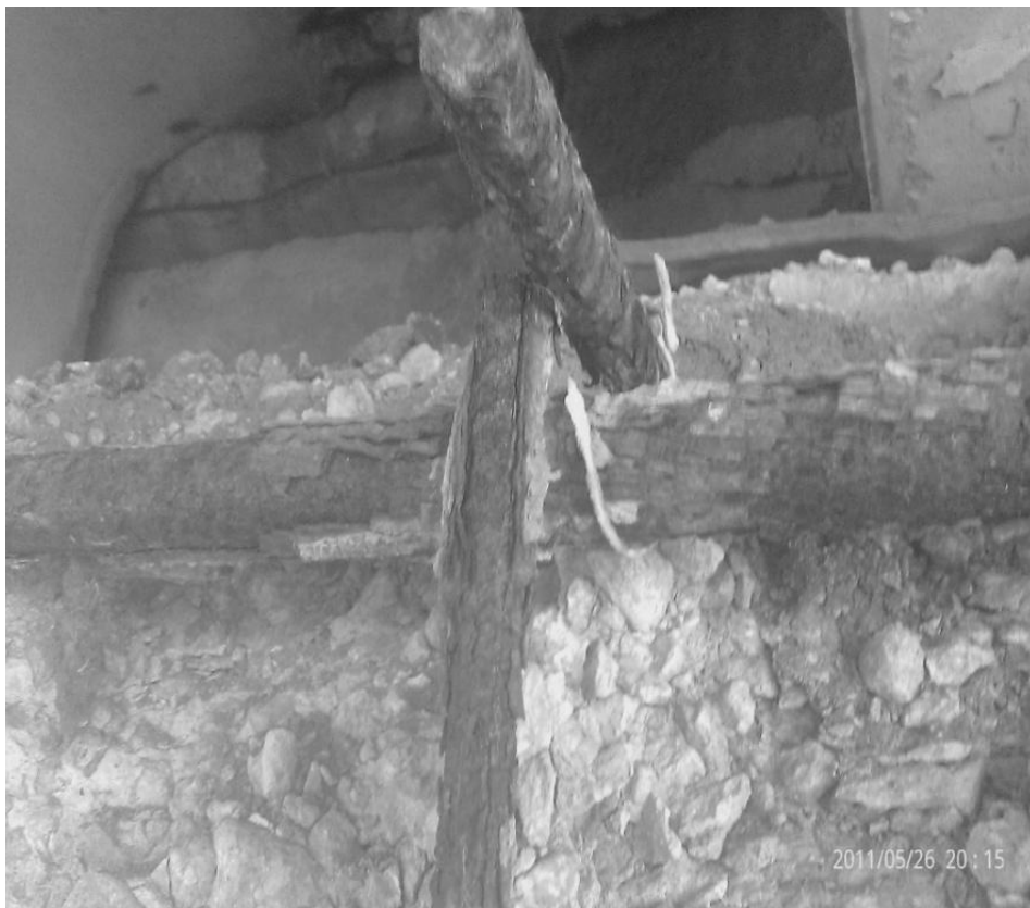
Рисунок 6. Разрушение бетона с обнажением и коррозией арматуры в ригеле
