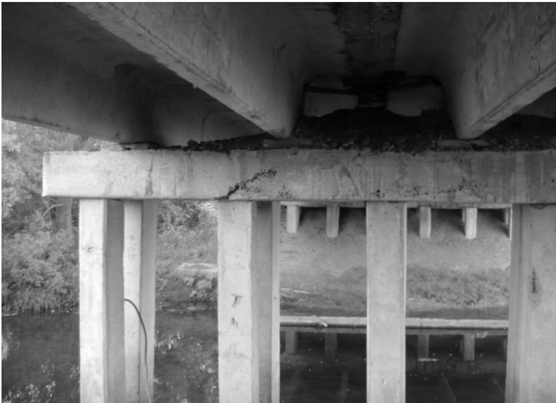
Рисунок 5. Подмостовое пространство. Наклонные трещины в ригеле
