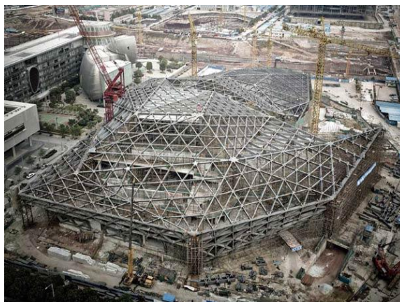
Рисунок 4. Сетчатые конструкции, примененные в оперном театре
