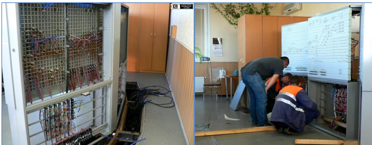
Рисунок 6. Работы по монтажу светодиодного табло
