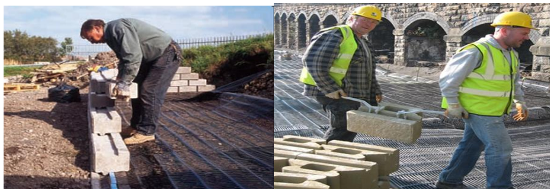
Рисунок 6. Перенос и установка модульных облицовочных блоков TW1
