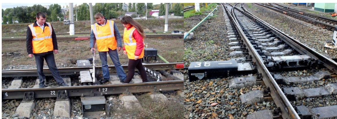
Рисунок 3. Стрелочный перевод, оборудованный современным шпальным электроприводом типа УПС
