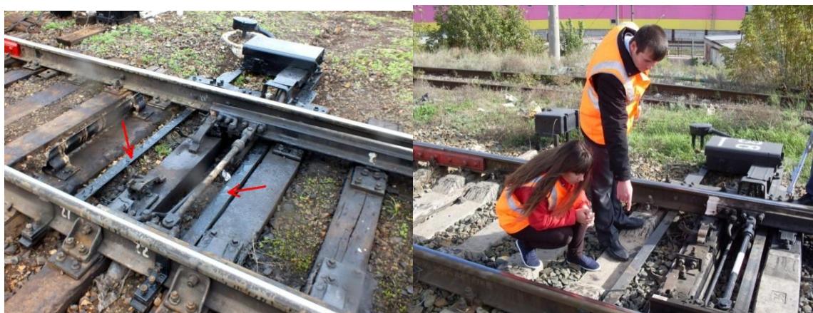
Рисунок 2. Стрелочный перевод с гарнитурными уголками привода серии СП
