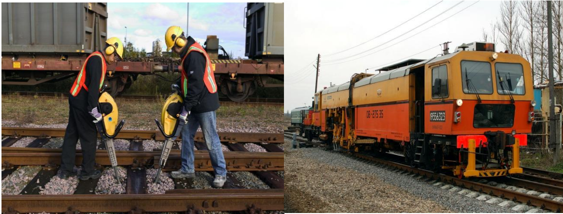
Рисунок 4. Работа выпровочно-подбивочно-рихтовочной машины и лектрошпалоподбойников
