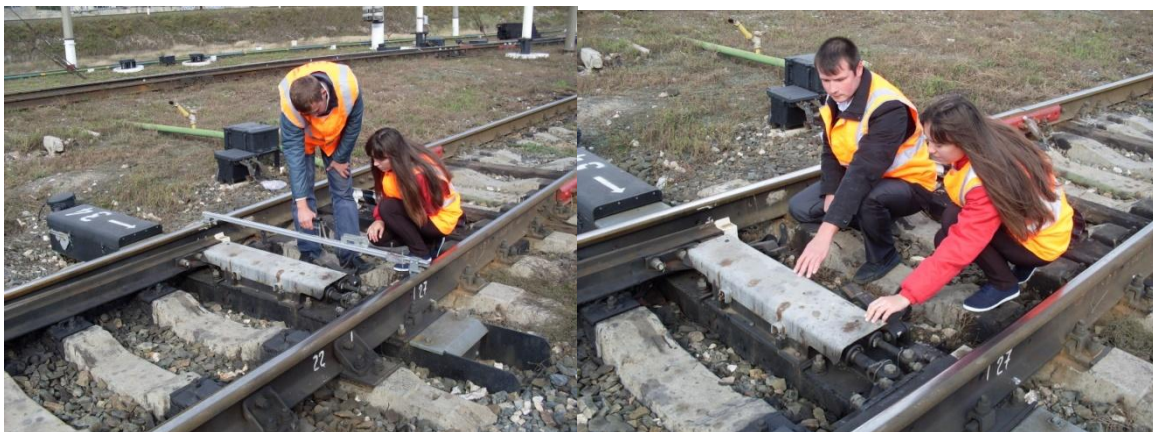
Рисунок 5. Подключение остряков к шпальному электроприводу типа УПС
