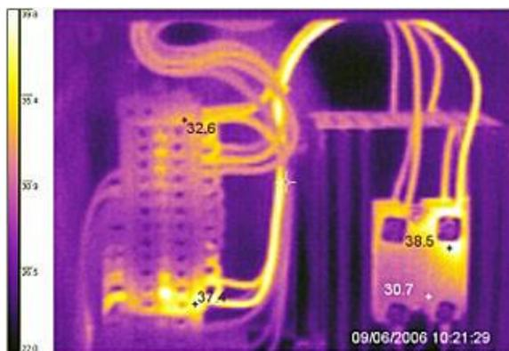
**Рисунок 1. Перегрев кабелей и ненадежного соединения**
