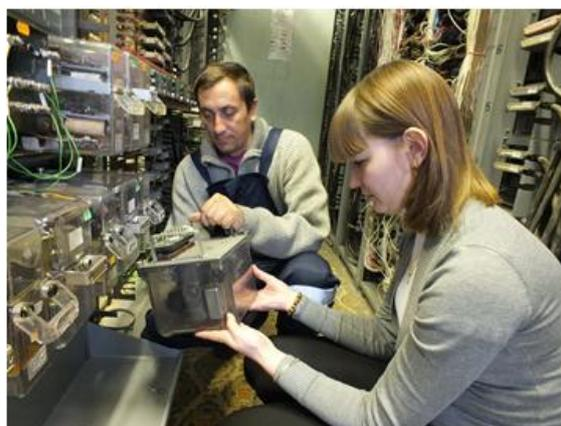
*Рисунок 1. Электромеханический кодовый путевой трансмиттер*
