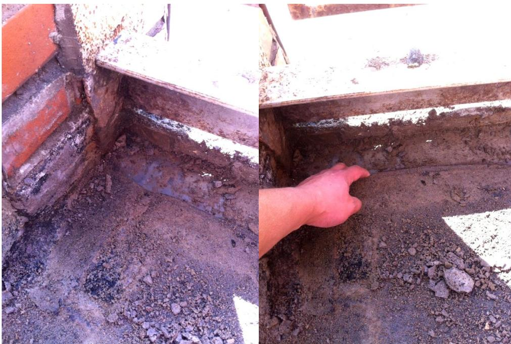
**Рисунок 5. Плинтус вдоль ограждения паркинга, отслоение гидроизоляционного ковра**
