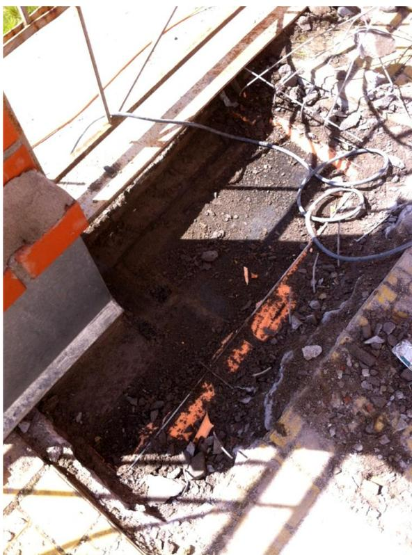
*Рисунок 4. Участок эксплуатируемой кровли после вскрытия*
