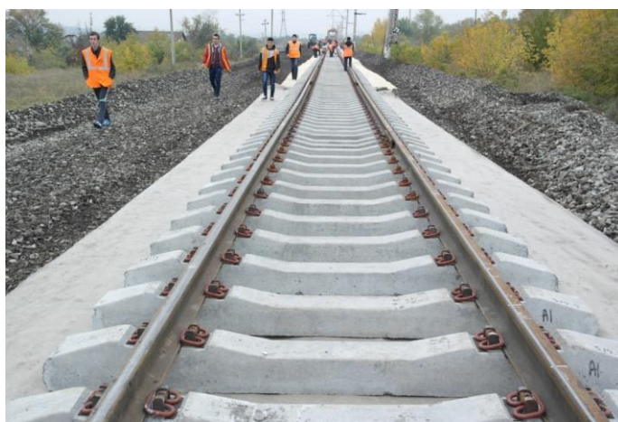
Рисунок 1. Укладка геотекстиля на участке Пост-6 — Спартановка
