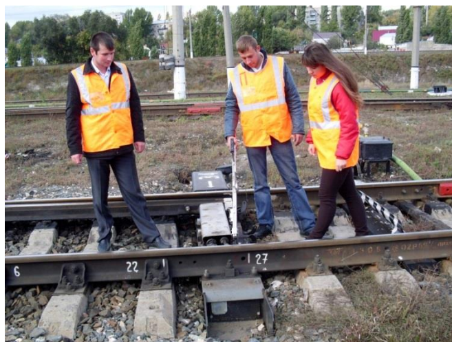
Рисунок 4. Шпальный стрелочный электропривод УПС
