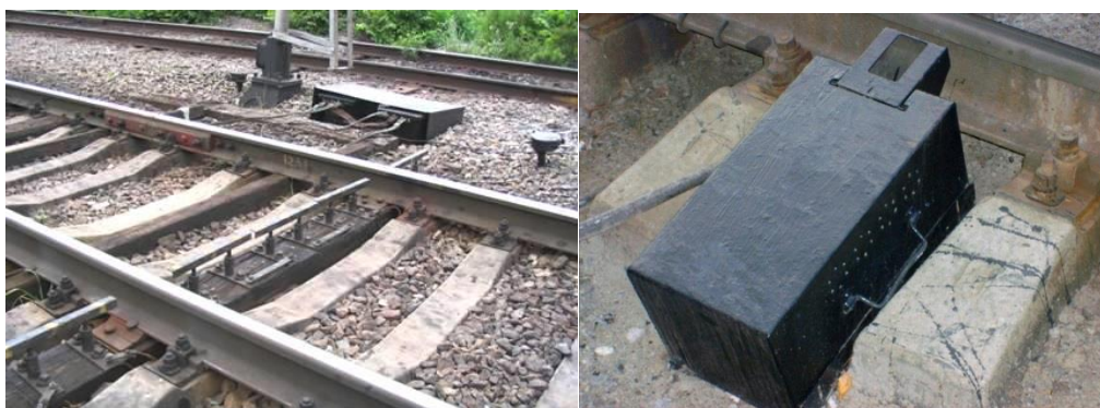
Рисунок 5. Установка УКСПС и КТСМ в шпальном ящике
