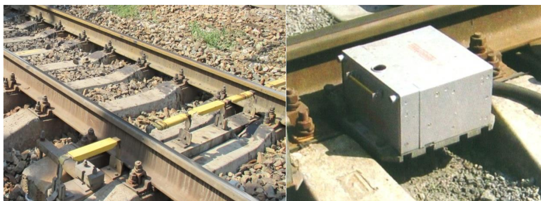
Рисунок 6. Установка УКСПС-П и КТСМ-02 в шпальном ящике
