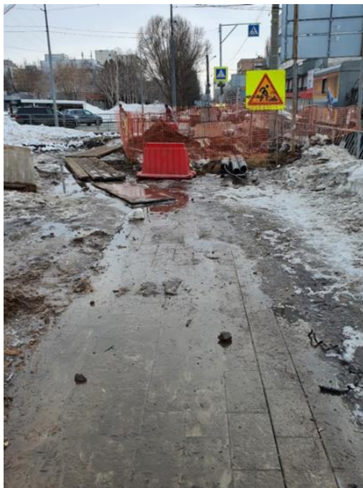
Рисунок 4. Ремонтные работы по замене коммуникаций, проложенных под пешеходной дорожкой
