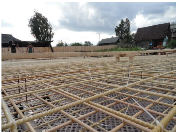
Рисунок 1. Каркас из монтажной арматуры
