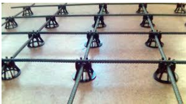
Рисунок 3. Укладка арматуры из пластика для фундамента
