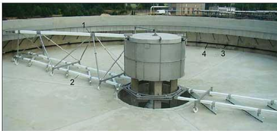
1 – устройство для сбора плавающих веществ; 2 – скребок; 3 – вспомогательное гладкое колесо; 4 – пластиковая цепь
