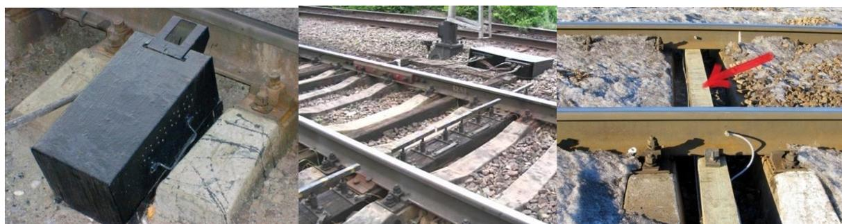
**Рисунок 1. Места препятствий на участке пути для работы машины ВПР**
