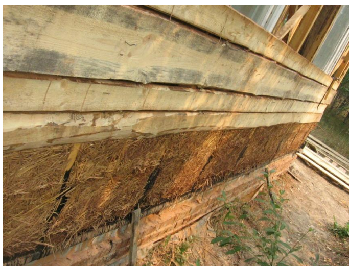
Рисунок 1. Применение самана в качестве утеплителя в стенах исследуемого дома
