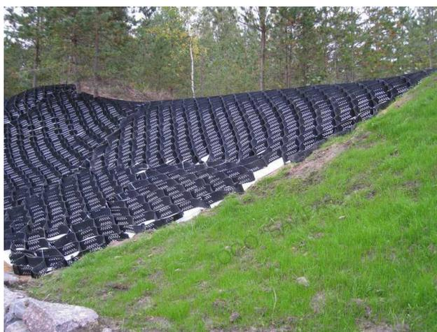
***Рисунок 4. Подпорная стенка из армированного грунта***
