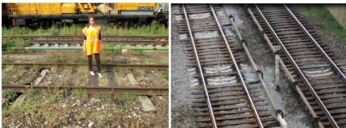
Рисунок 3. Установка в деревянный путь железобетонных шпал
