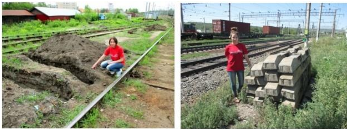
Рисунок 2. Подготовка к смене деревянных и железобетонных шпал
