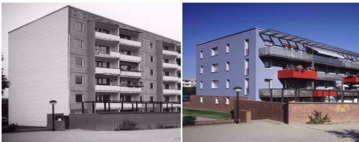
***Рисунок 2. Реновация панельного дома в городе Лайнефельд. Германия***
