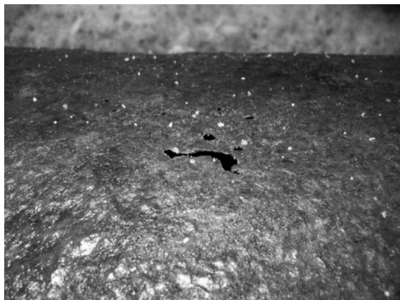
Рисунок 3. Разрушение тепловой трубы в результате совместного действия общей и язвенной коррозии
