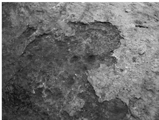
Рисунок 1. Язвенная коррозия на наружной поверхности тепловой трубы
