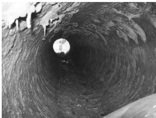
Рисунок 2. Внутренняя поверхность трубы для подачи воды
