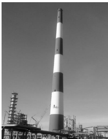
Рисунок 2. Железобетонная дымовая труба
