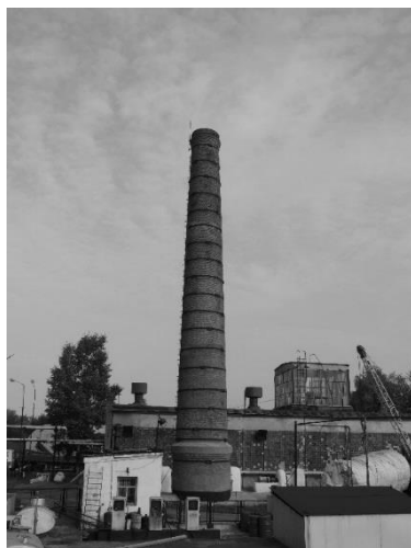
Рисунок 1. Кирпичная дымовая труба
