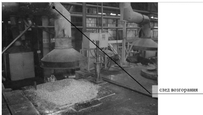
Рисунок 1. Следы возгорания системы промышленной вентиляции в механосборочном производстве ОАО «АВТОВАЗ»
