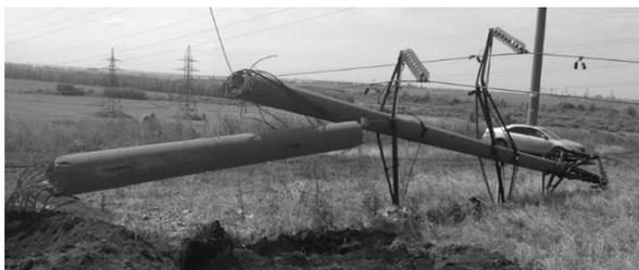
***Рисунок 1. Разрушение опоры ВЛ 110 кВ, выполненной из железобетонной стойки СК-1***
